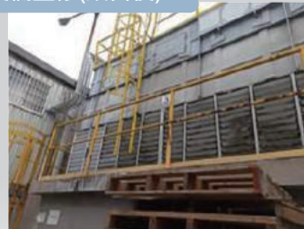
護欄整修(改善後)
